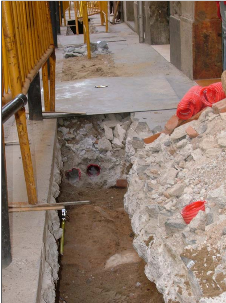
Fotografia 5: Vista longitudinal de la Rasa 1000 i del mur UE 1004.
