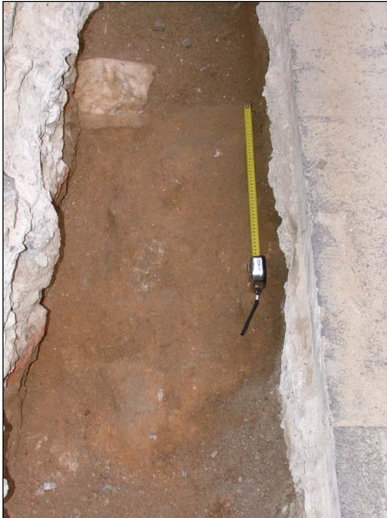
Fotografia 6: Vista general de la planta del mur UE 1004.
